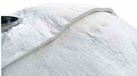
Μόνωση με δυο στρώσεις κεραμοβάμβακα.
