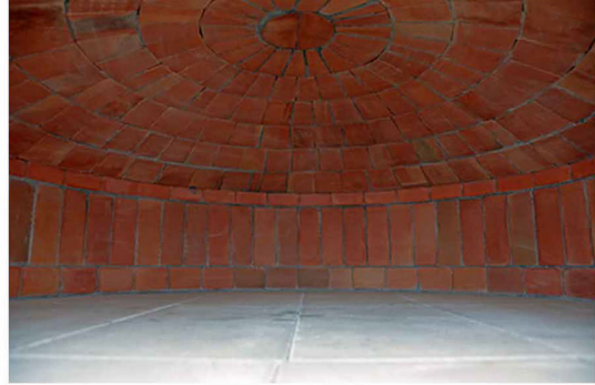
Θόλος ενιαίος κατασκευασμενος απο πυρότουβλο
